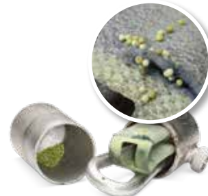
Sin mantenimiento de la climatización
