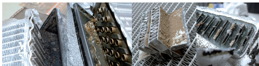
Zdjęcie 2: Osady takie jak rdza, kamień, środki uszczelniające oraz inne ciała obce powodują zatory i zmniejszają wydajność chłodzenia
