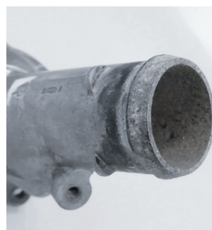
Ilustracja 3: Przed montażem starannie oczyszczenie skorodowanej powierzchni
