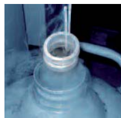
Bild 4: Zur Montageerleichterung werden die Ventilsitzringe mit flüssigem Stickstoff abgekühlt.
