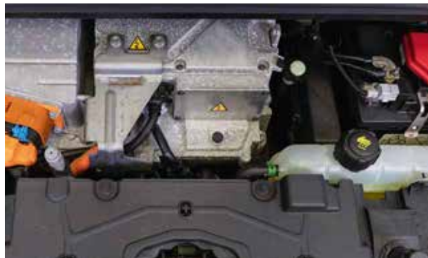
Componentes de alta tensão no compartimento do motor
