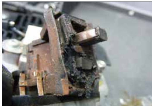
Fig. 2.02 – Queima de revestimento da vedação das escovas do regulador de tensão.
