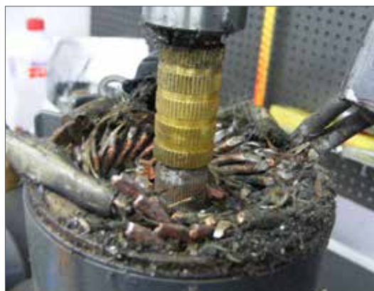
Fig. 2.01 – Coletor e porta escovas completamente destruídos.
