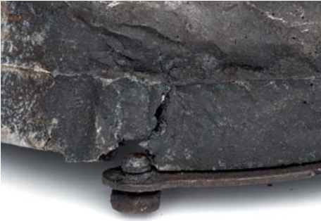
Fig. 1 Fisura en la carcasa de la turbina
