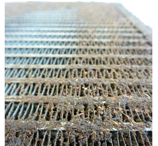
Resim 2 Tıkanmış evaporatör
