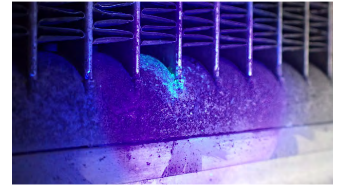
Resim 2 Kondansatörde paslanma
