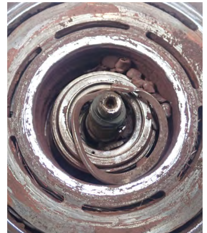
Rys. 2 Uszkodzone łożysko kulkowe
