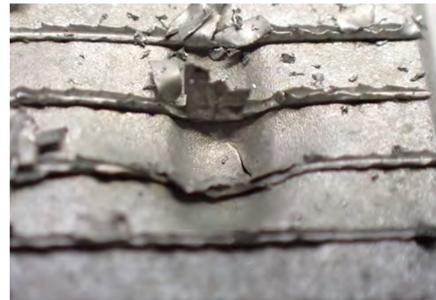
Fig. 2 Déformation et fissure
