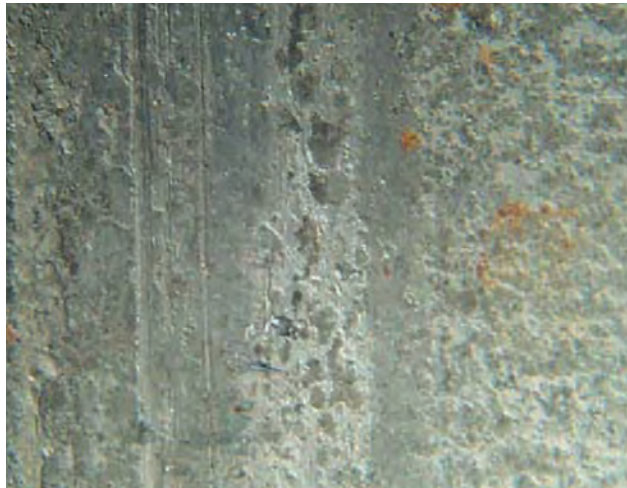
Resim 1b Yakından görünümde açıkça görülüyor: hasar görmüş yatak malzemesi
