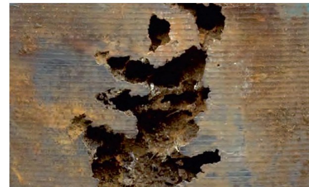
Rys. 1b Zbliżenie na tuleję cylindrową z ostrymi krawędziami i powiększającymi się do wewnątrz otworami
