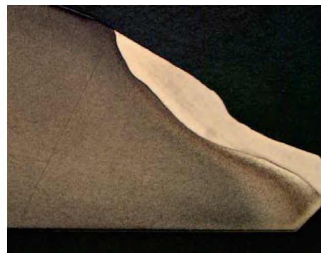
Fig. 3 Usure extrême de la surface d'étanchéité (blindage stellite)
