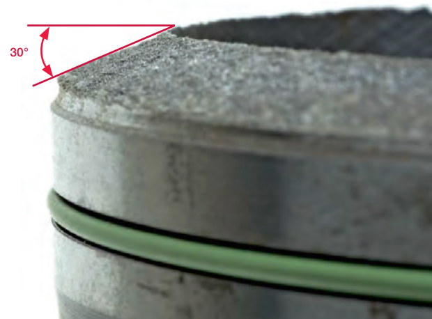
Fig. 2 Rupture grossière selon un angle d'env. 30°
