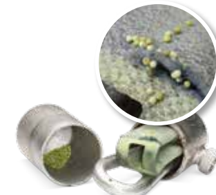
Sem manutenção do ar-condicionado
