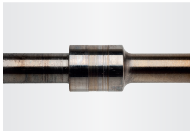
Ilustracja 4 Wyraźne ślady zużycia na wale w łożyskowaniu
