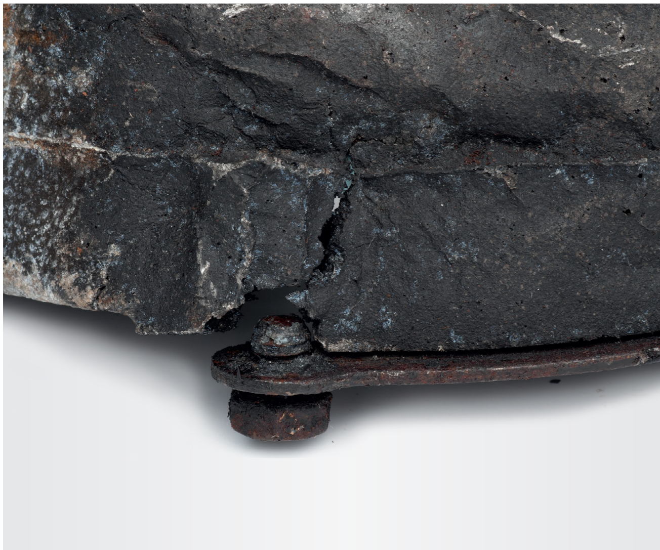
Ilustracja 1 Pęknięcie korpusu turbiny
