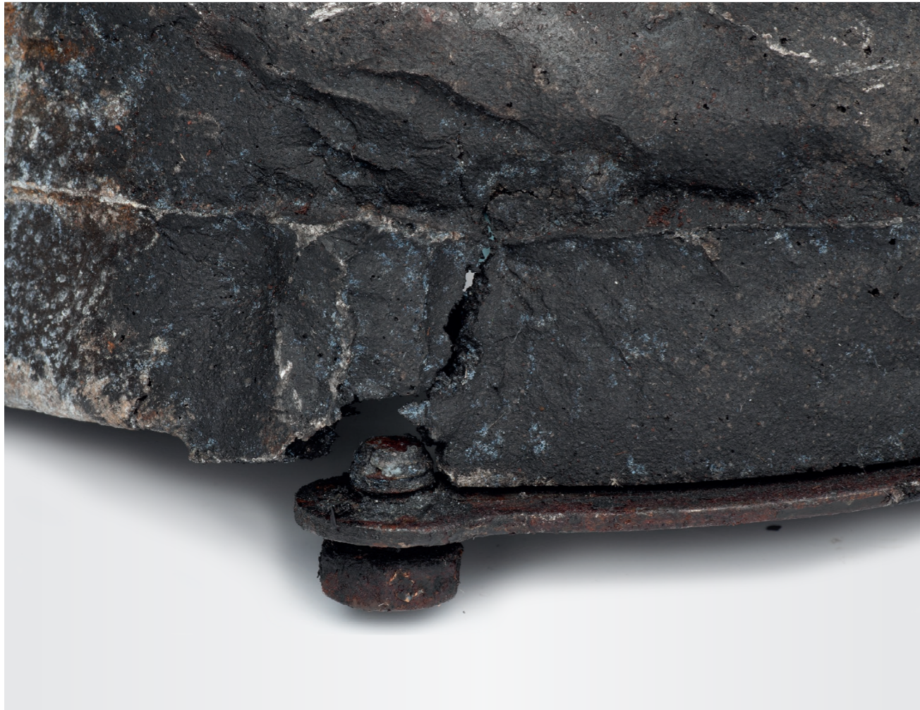
Fig. 1 Fissure dans le carter de la turbine
